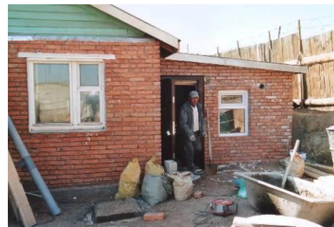
rechts: de aanbouw waar de tank, de douches en de wc's in komen
